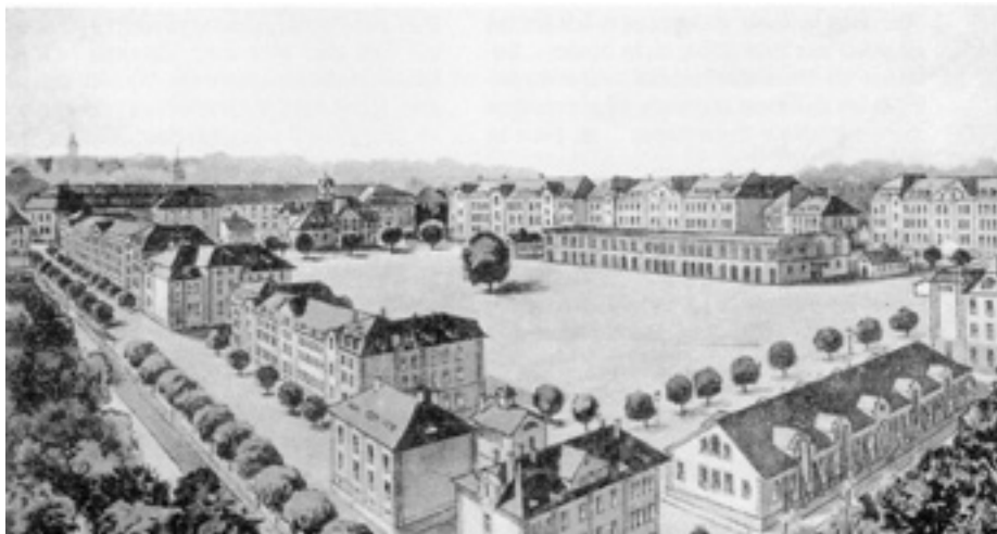
Historische Abbildung des Ludwig-Wilhelm-Kaserne, des heutigen Canrobert-Geländes - das Mannschaftsgebäude II wurde 1932 abgerissen.
